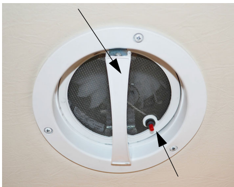
Fan Power Switch
